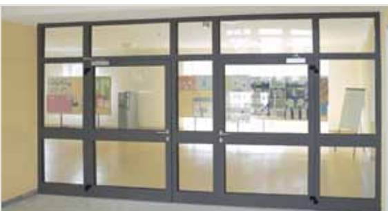
Vetrata tagliafuoco in alluminio, verniciata Ral 7016, composta da due fianchi luce fissi, da un sopraluce fisso e da due aperture ad una anta.
